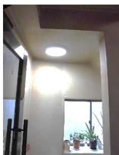
本社2F、3F、4F、5F階段通路 (2022年3月施工)
