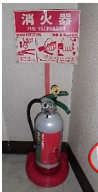
設置場所の再確認
