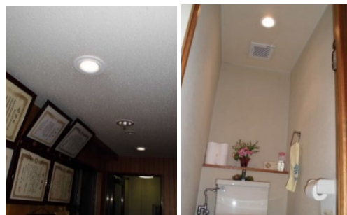
本社通路、トイレ(2018年12月施工)
