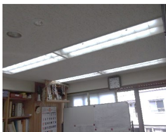
本社2F、3F (2015年4月施工)
